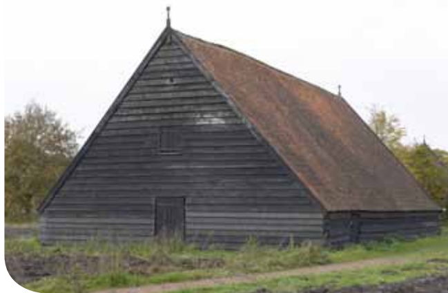
Tabaksschuur in Amerongen
